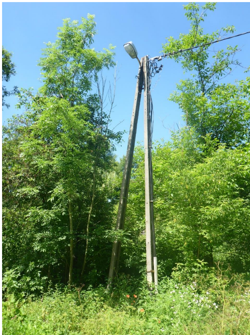
Fotografia 1 Oświetlenie będące w złym stanie technicznym w miejscowości Sworoń
