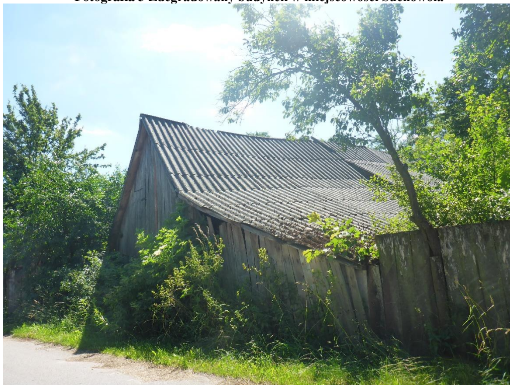
Fotografia 3 Zdegradowany budynek w miejscowości Suchowola
