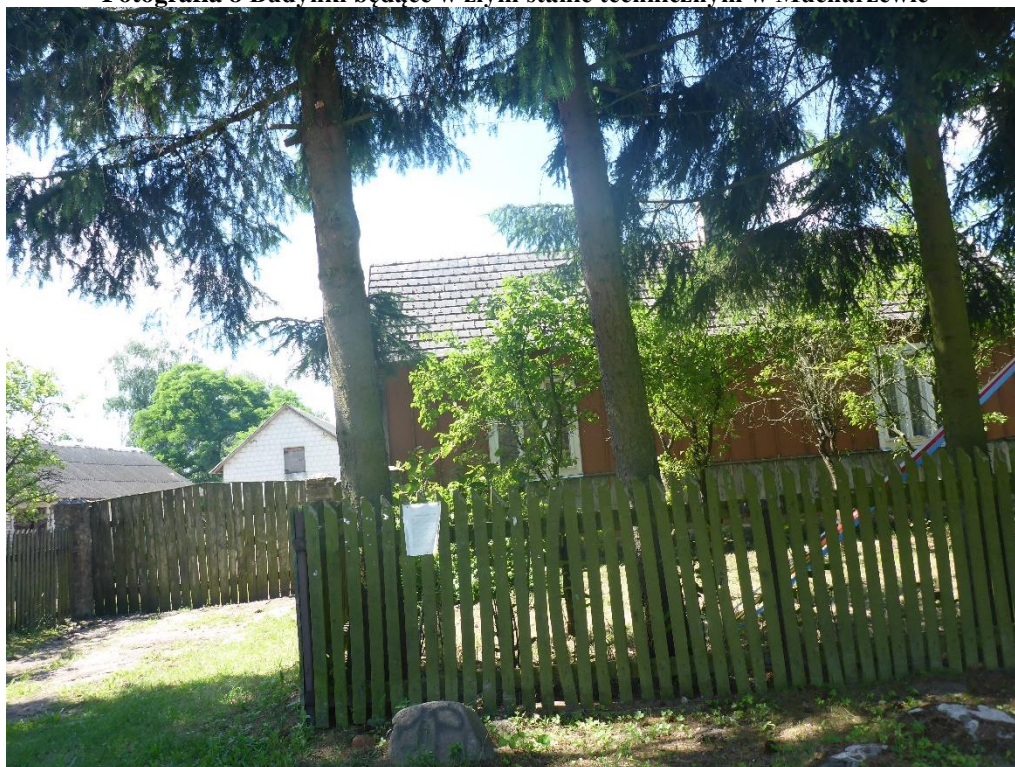
Fotografia 8 Budynki będące w złym stanie technicznym w Mucharzewie
