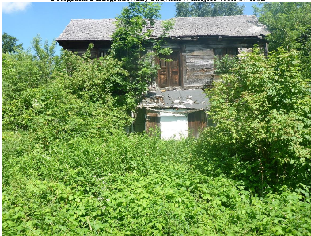
Fotografia 2 Zdegradowany budynek w miejscowości Sworoń
