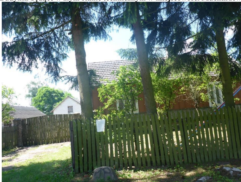
Fotografia 5 Budynki będące w złym stanie technicznym w miejscowości Mucharzew – Podobszar I
