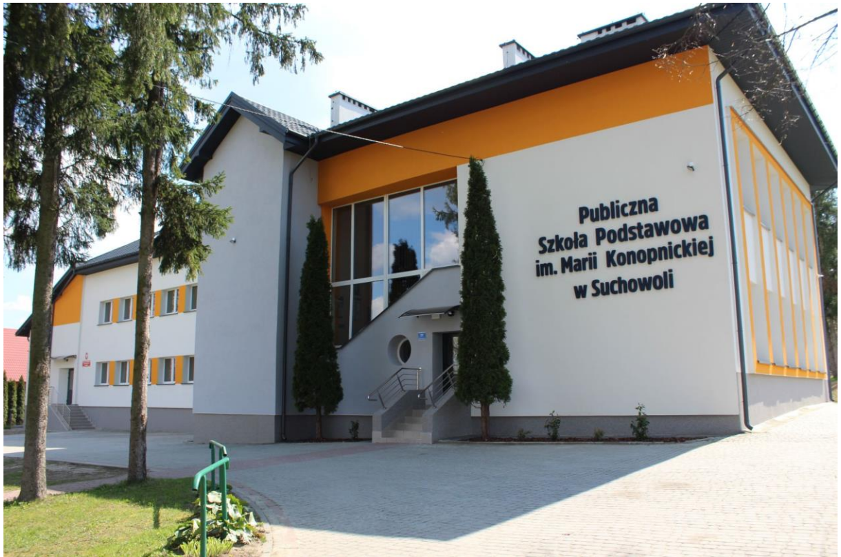
Termomodernizacja PSP w Suchowoli
