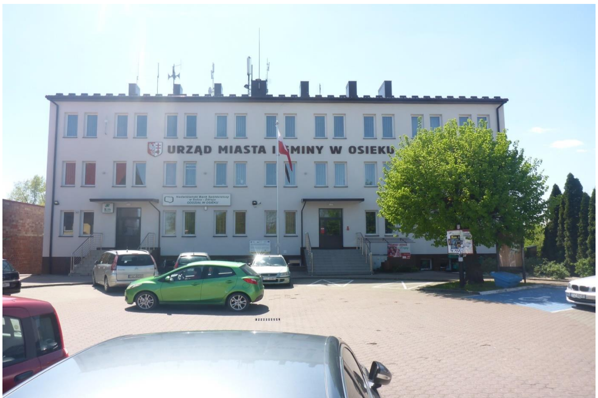
Termomodernizacja budynku Urzędu Miasta i Gminy w Osieku
