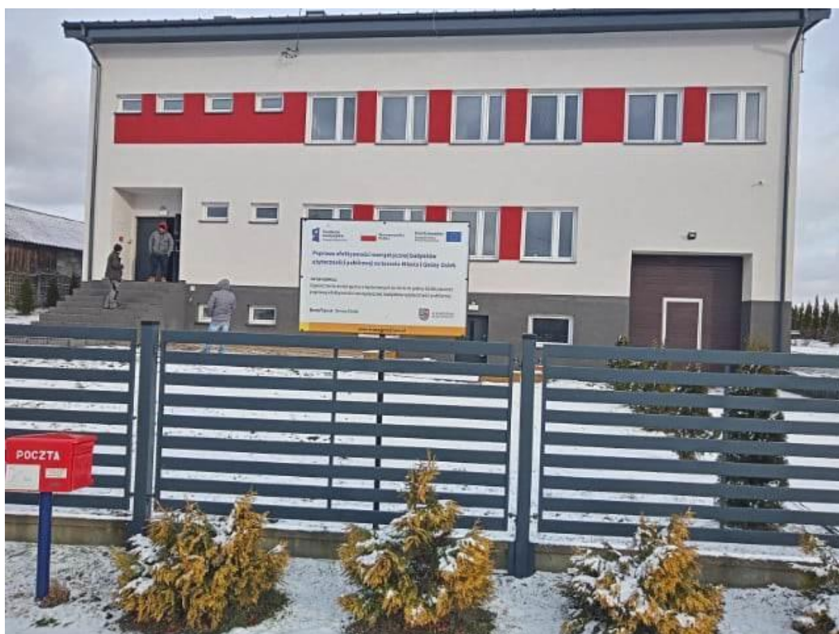
Termomodernizacja OSP Bukowa
