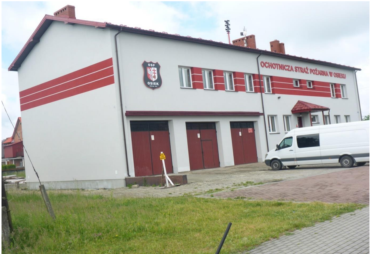
Termomodernizacja OSP Osiek
