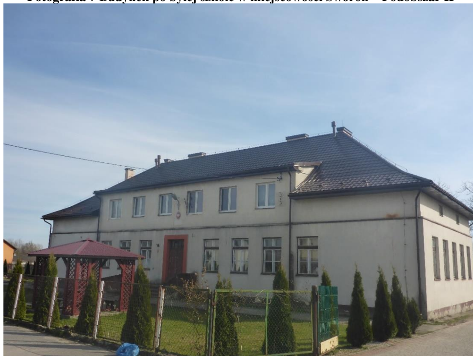
Fotografia 7 Budynek po byłej szkole w miejscowości Sworoń – Podobszar II
