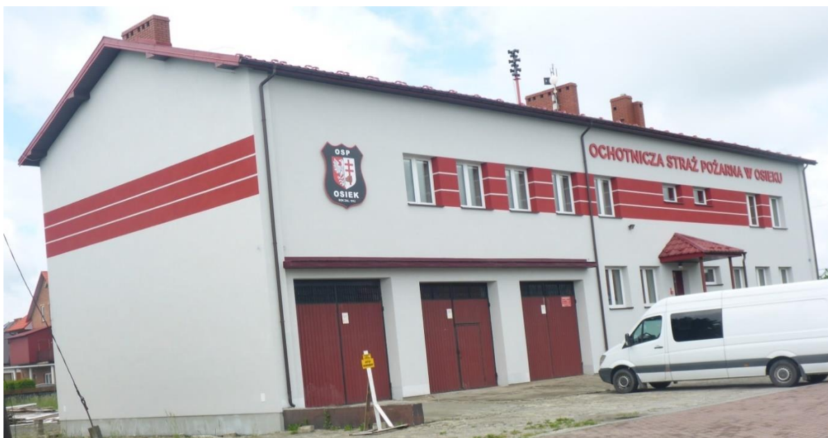
Termomodernizacja OSP w Osieku
