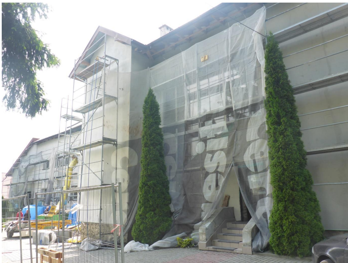
Termomodernizacja PSP w Suchowoli
