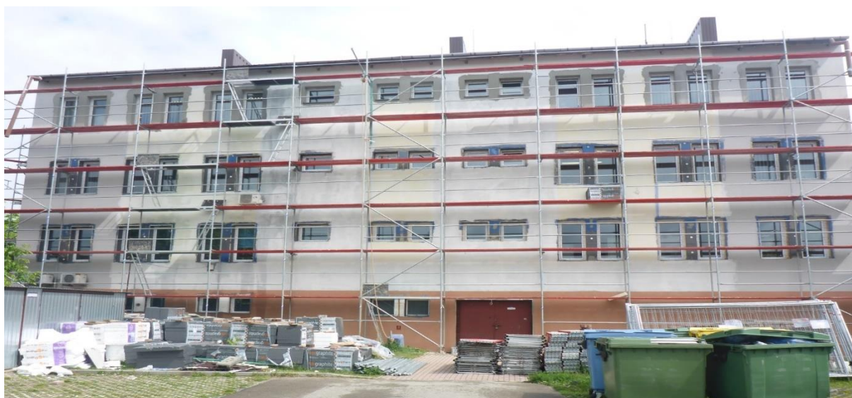
Termomodernizacja budynku UMiG w Osieku
